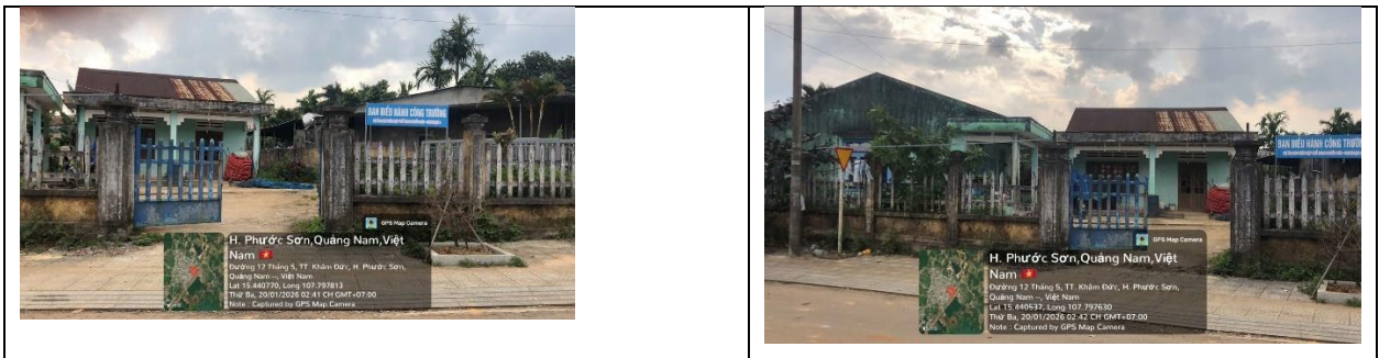
Hình công trình hiện trạng
